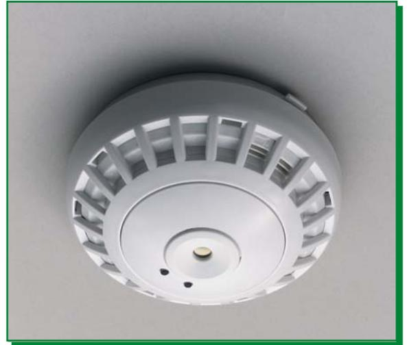
“门禁尾随探测器基于高精度的热成像人员统计技术，根据体热进行探测和跟踪”
